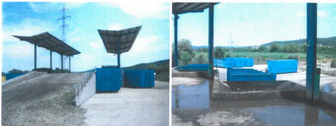
Figură 2-8 Stația de transfer și Centrul de colectare Beclean
