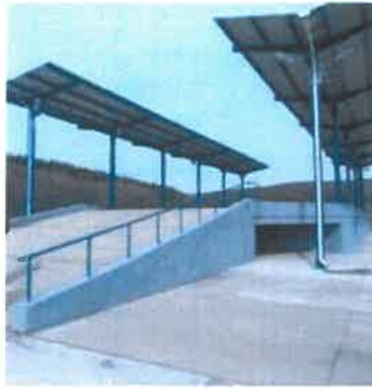
Figură 4-1 Stație de transfer
